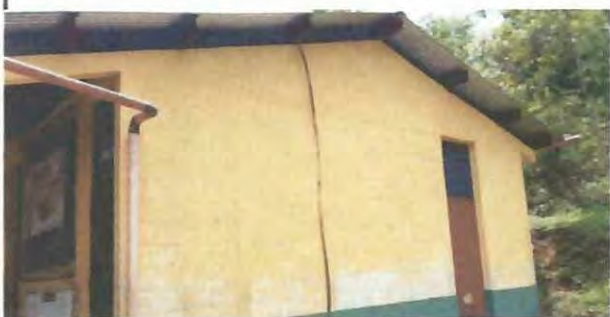
Foto 5: CAMBIO DE PNTURA DE LAS PAREDES POR DETERIORO.
